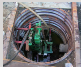
到達立坑内の引込み装置(LW56)
