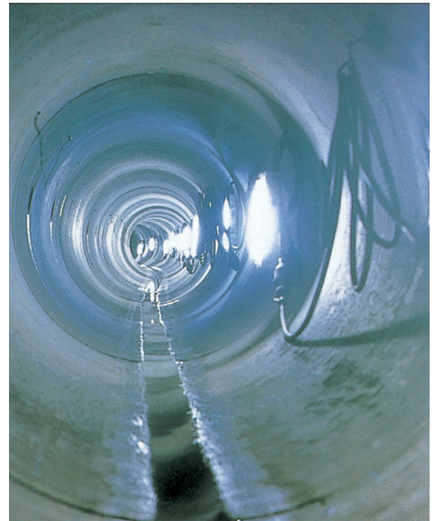
φ800 曲線100R管内状況
