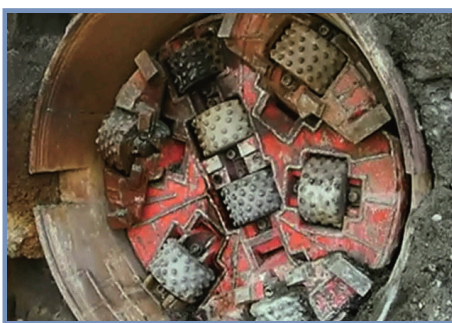
カッタヘッドの拡縮・回収状況
